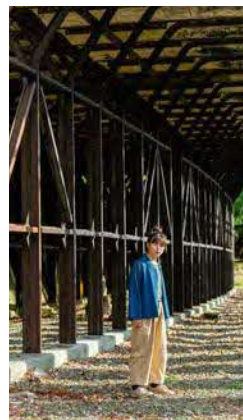
山中ロックシェッドの上部には、信号所の退避線路を守るための構造物も残っています。
