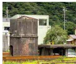
今庄駅給水塔・給炭台
